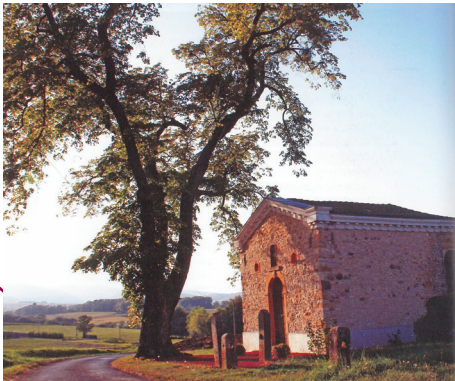
Chapelle des Rues, Arch. mun. Arnas
